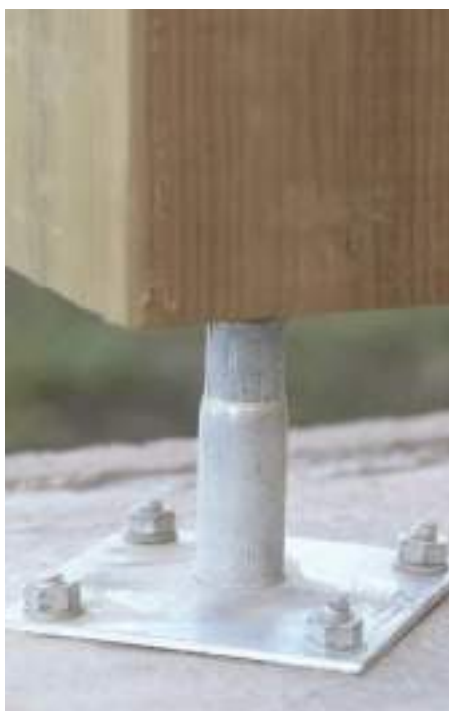
PIEDS DE POTEAU
